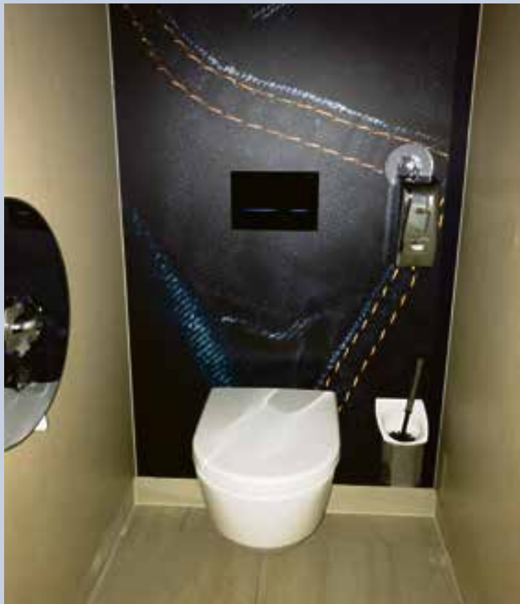
De Geberit Sigma80 touchfree bedieningsplaat voor extra hygiëne maakt deel uit van het toilet.
