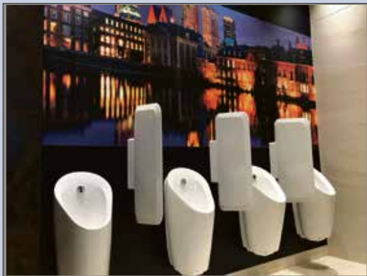
Preda urinoirs van Geberit zijn onderdeel van het modulaire systeem en er zijn Geberit urinoirscheidingswanden gemonteerd.
