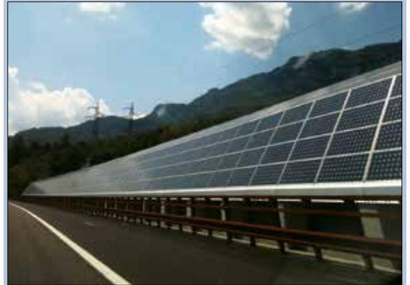
Een geluidswal met zonnepanelen langs de snelweg bij Maastricht.
