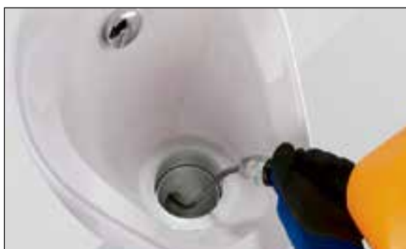
Het sifonhuis op Geberit urinoirs is bijzonder ruim, waardoor u direct toegang heeft tot het afvoersysteem.
