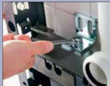
Montagebeugels worden gebruikt om het frame vast te zetten aan de bouwconstructie.
