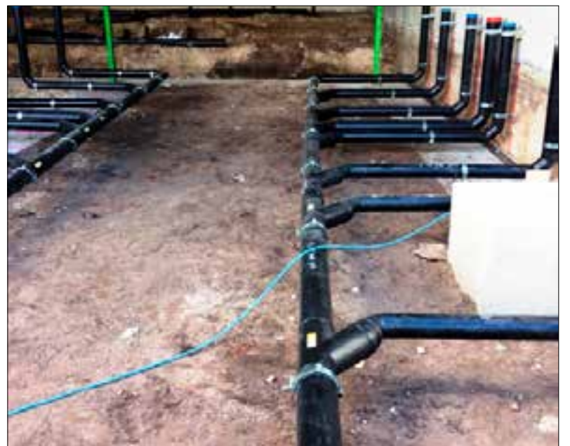
Onder de tribunes van het nieuwe Thialfflight een netwerk afvoerleidingen van Geberit.
