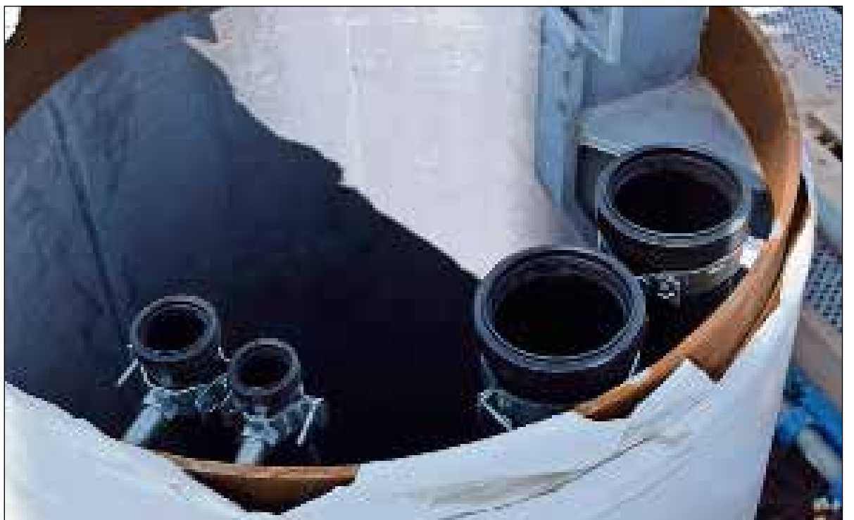
In de zeven zuilen die het dak ondersteunen zitten de leidingen van Geberit al voordat het dak erop komt.
