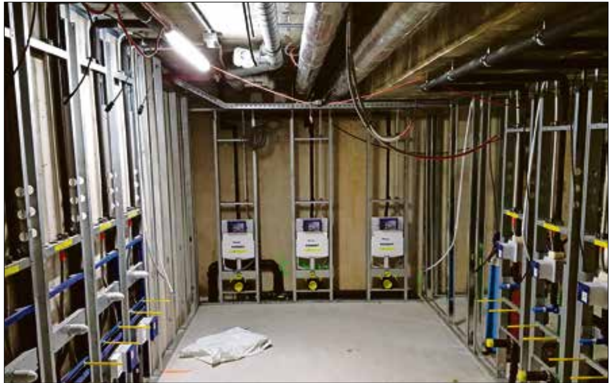
De urinoirs, toiletten en kranen zijn geïnstalleerd in Huter prefab-elementen van Geberit.
