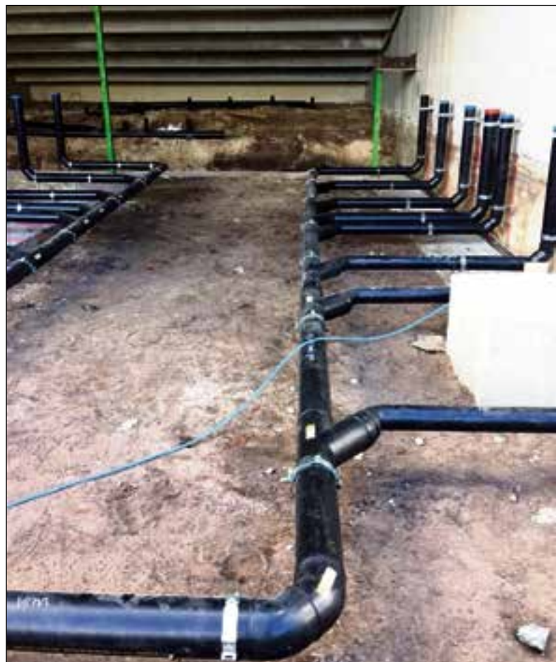
Onder de tribunes ligt een compleet netwerk van afvoerleidingen van Geberit.
