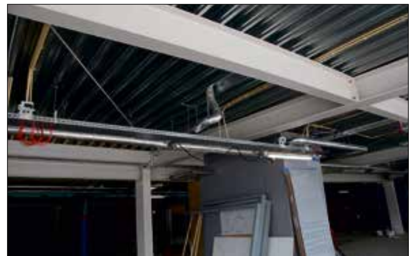
In Thialf is Geberit Pluvia, waarvan de afvoerleidingen zijn geïsoleerd, verwerkt.
