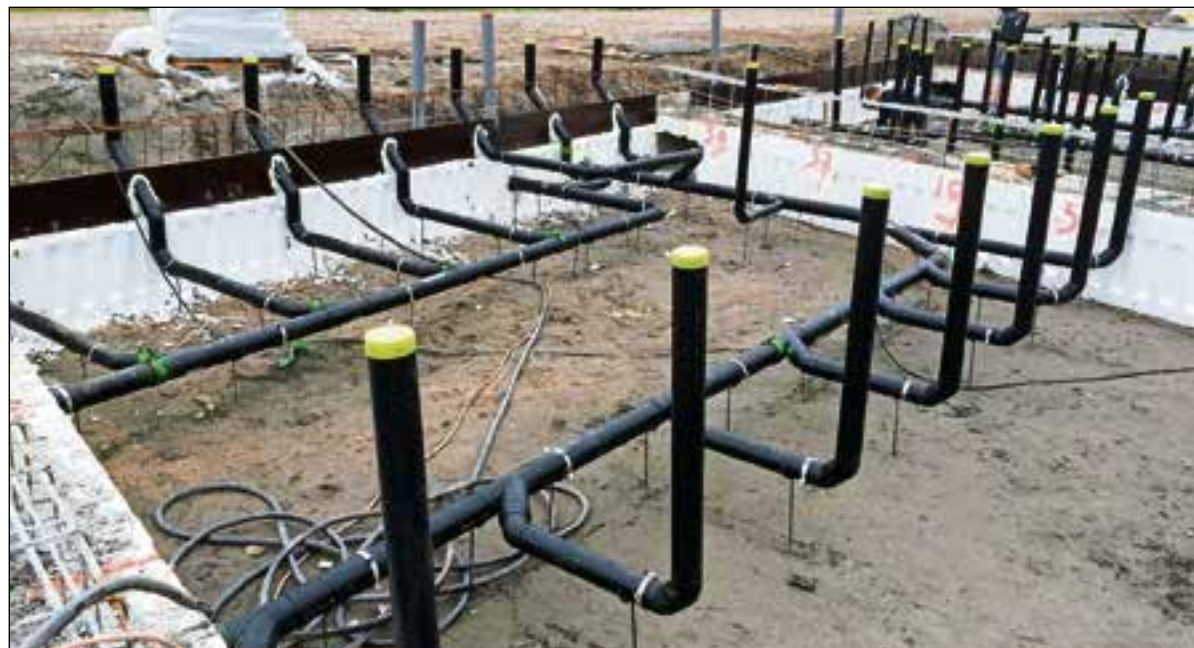
Vuilwater wordt afgevoerd via Geberit PE afvoerleidingen.
