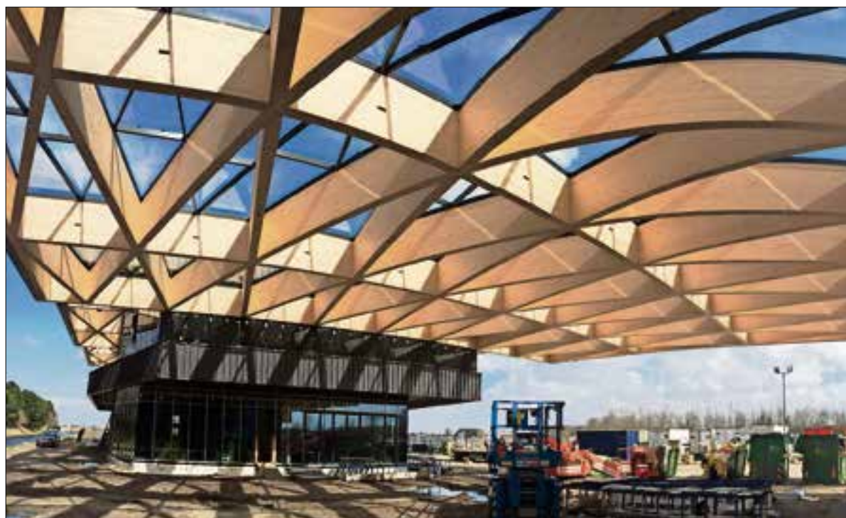
Het nieuwe markante entreegebouw van Keukenhof nadert de voltooiing (inmiddels is het opgeleverd).
