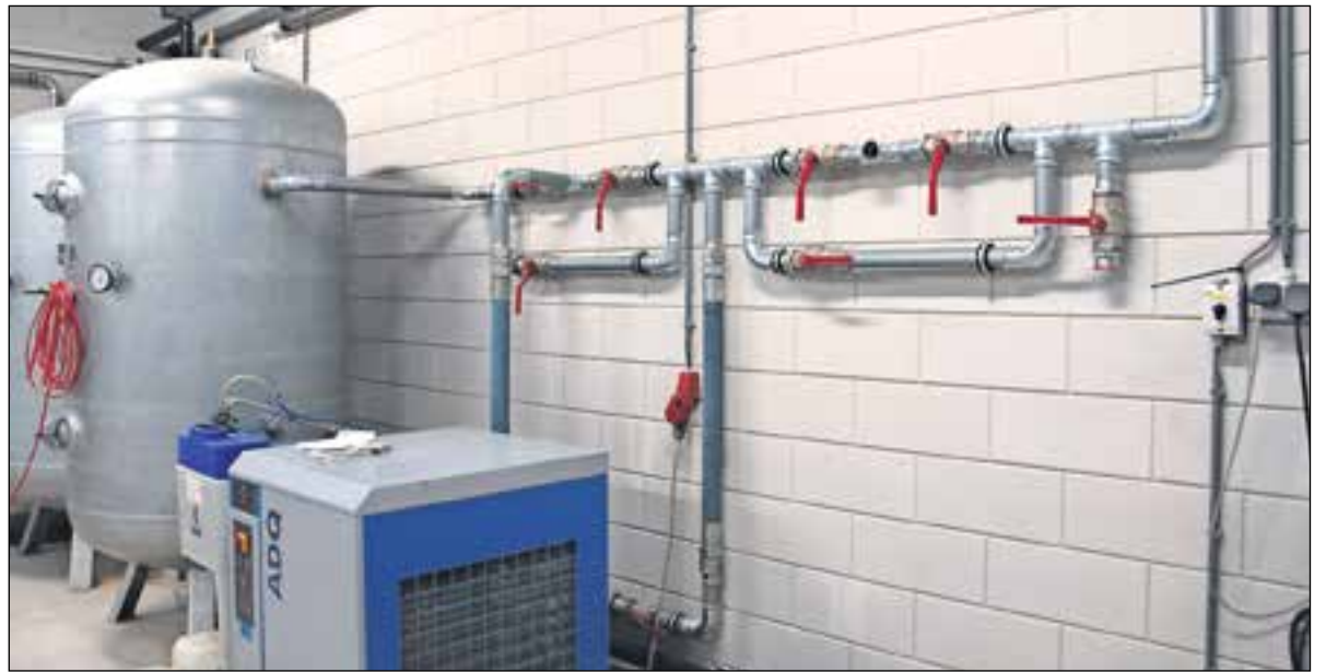
Een fraai stukje leidingwerk met Geberit Mapress in het ketelhuis.
