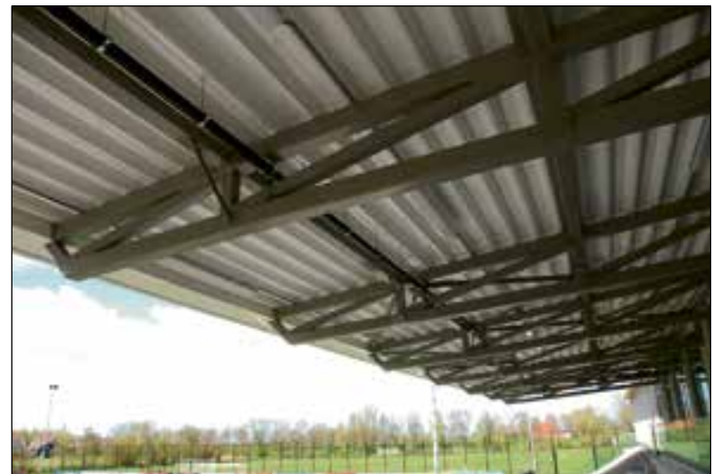
Het Geberit Pluvia systeem is voor de toeschouwers op de tribune duidelijk zichtbaar.
