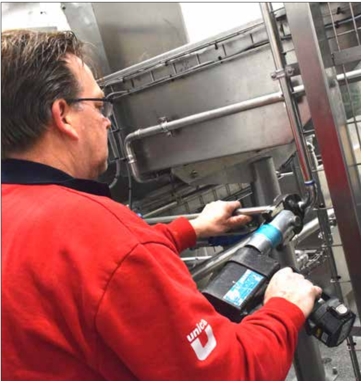
De Geberit Mapress leidingen worden keurig afgeperst.
