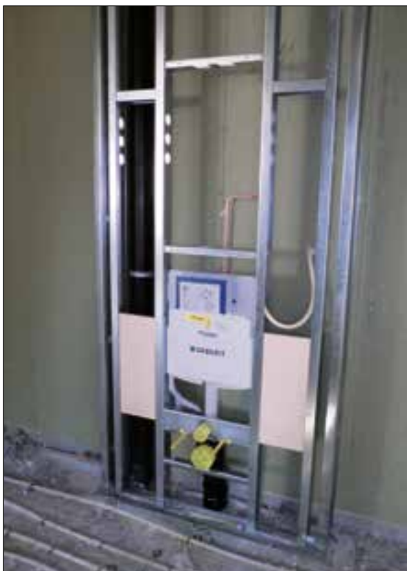
Het frame wordt kant en klaar aangeleverd en ingebouwd.
