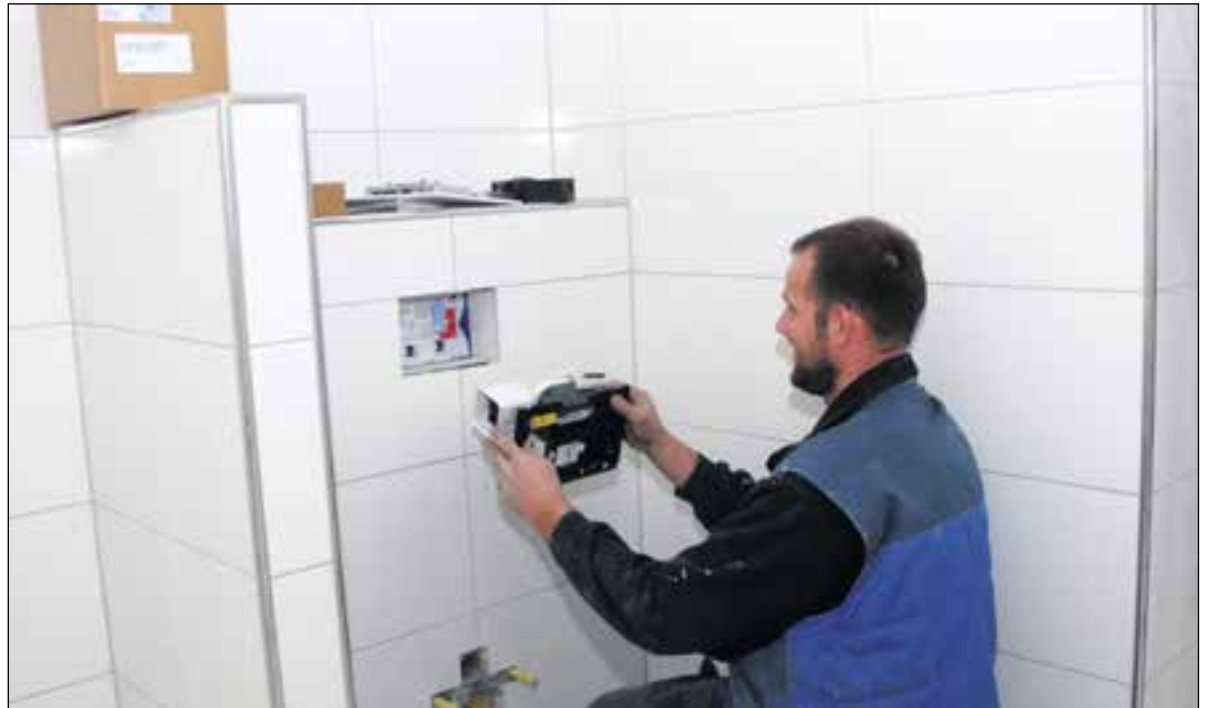
Een installateur van Alferink Installatietechniek bouwt een van de Geberit DuoFresh inbouwreservoirs in.
