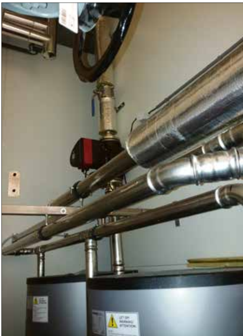
In de technische installatie bij Mora is Geberit Mapress gebruikt.
