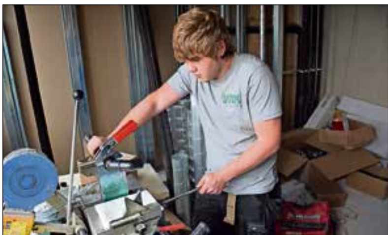
Ter plekke is het nodige aan leidingwerk geprefabd.
