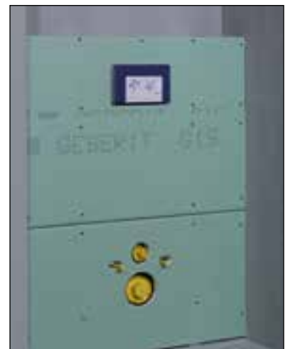
Het GIS installatiesysteem wordt afgewerkt met Geberit gipskartonplaten.
