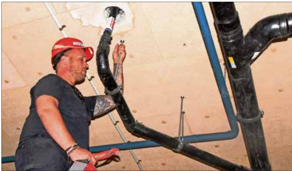
Een monteur van Loohuis-Meulenbeld legt in de toekomstige parkeergarage een leidingnetwerk aan.
