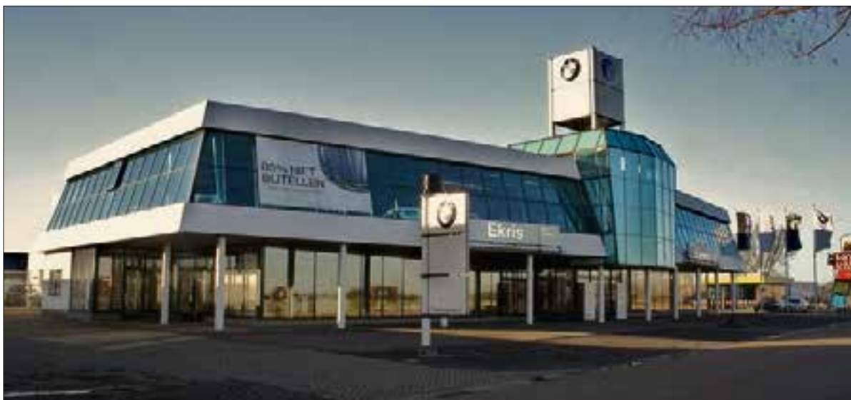
Ekris BMW-MINI Nijkerk is een van de showrooms waar Madern Techniek technische werkzaamheden heeft verricht.
