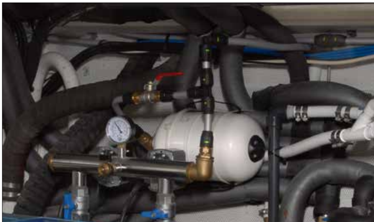
In het ruim van een motorjacht dat bij StormYachts wordt gebouwd, wordt Geberit PushFit geïnstalleerd.
