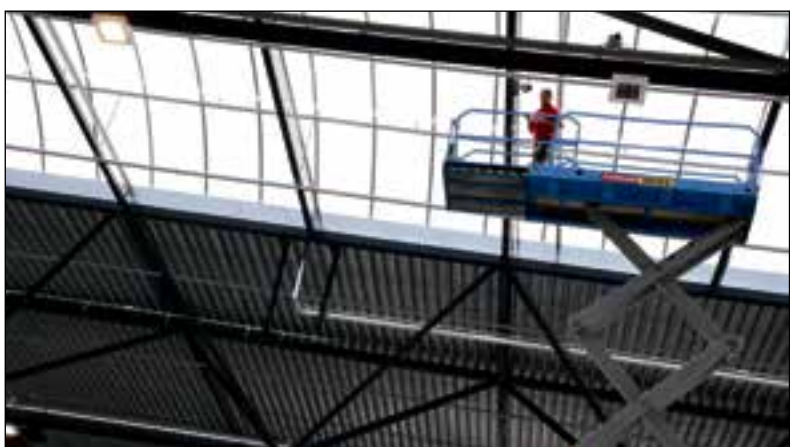
De leidingen van Geberit Pluvia en de noodoverstort in het nieuwe deel van de Brabanthallen.
