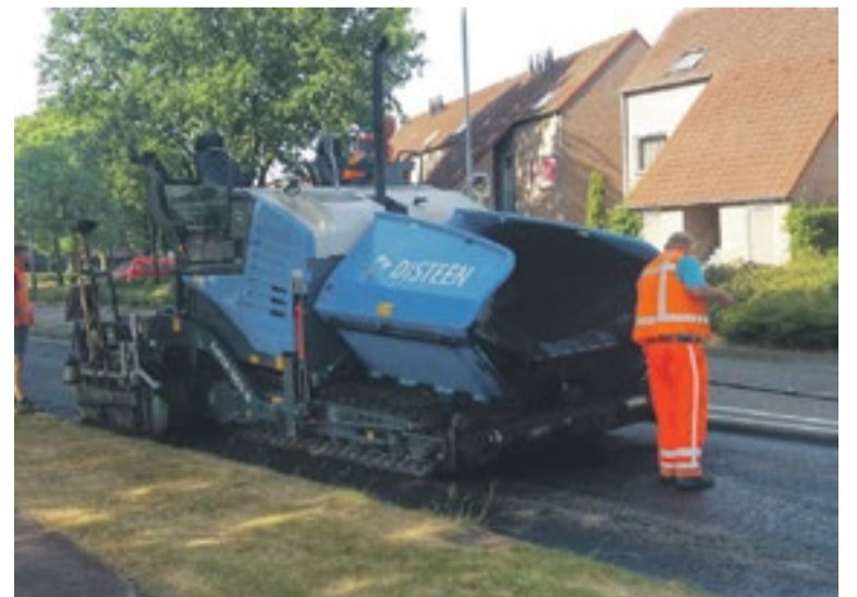
Eerdere asfaltwerkzaamheden bij De Dom
