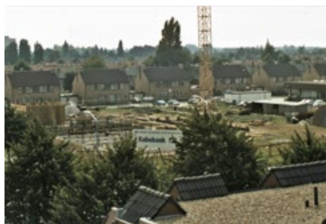
Hoofdkantoor Schimmerik in aanbouw, 1979. FOTO: Archief Erfgoedhuis.
