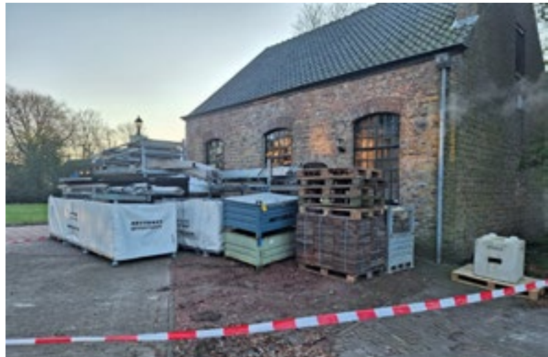
Het Heemhuis van heemkundekring De Drijehornick, door de opslag van bouwmaterialen nagenoeg onbereikbaar. Foto: Ruud Bovens.
