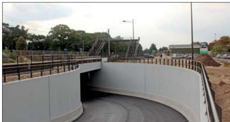
A.s. zaterdag is het nog mogelijk om lopend 'onderdoor' te gaan. Daarna is de tunnel alleen voor snelverkeer met een maximum van 30 km/u toegankelijk. (foto Henk van de Bunt).
