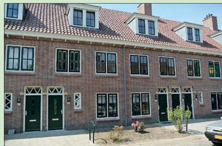
Dit blok wordt inmiddels weer energiezuinig bewoond. Het duurt nog tot het tweede kwartaal van 2015 eer alle woningen onder handen genomen zijn.
