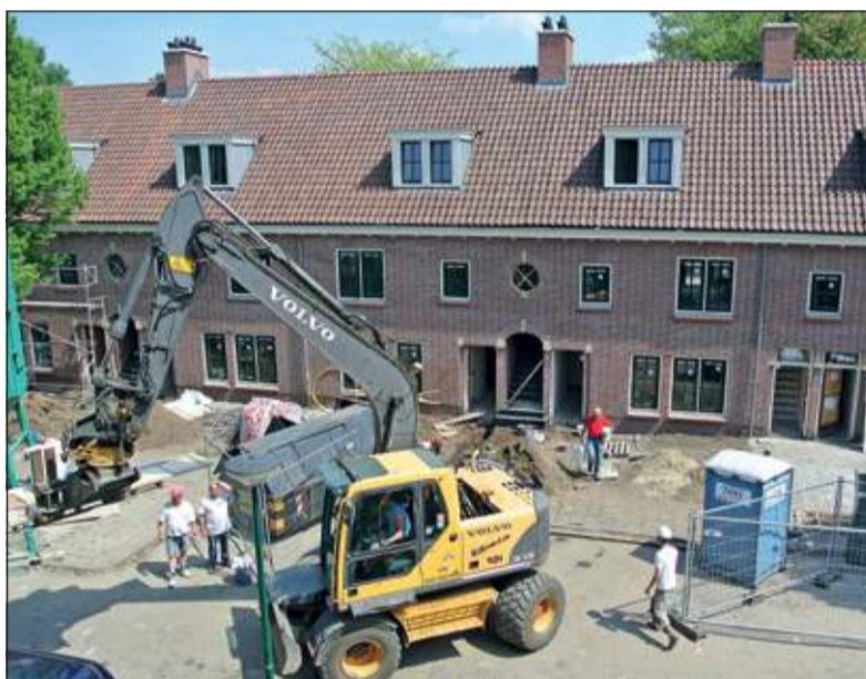
Renovatie Burgemeester van Heemstrakwartier.
