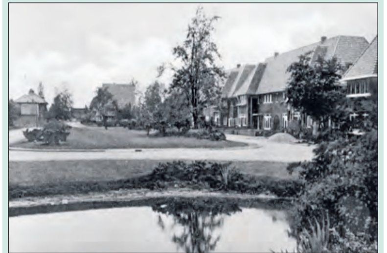
Woningen Park Arenberg op ongeveer 500 meter van de Werken bij Griffenstein. (Bij het artikel: 'Bouwen binnen verboden kringen'.)
