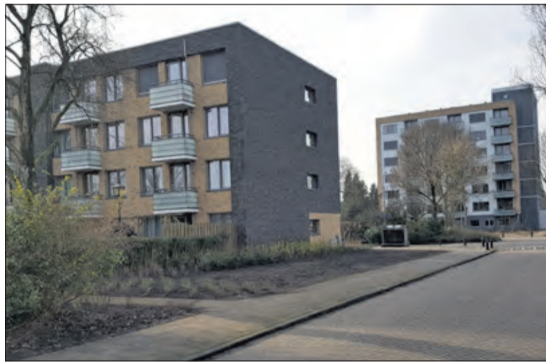
De verduurzaamde woningen staan er ook prachtig bij. [foto Henk van de Bunt]
