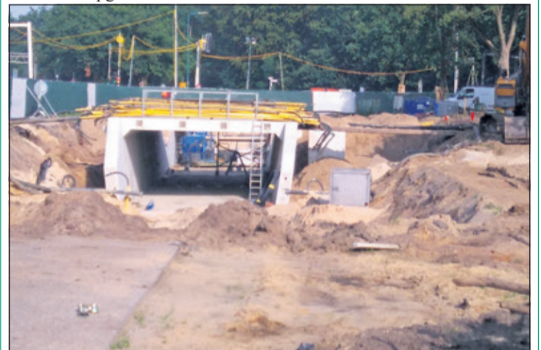
Begin augustus werd gestart met de aanleg van de fietstunnel en de uitvoering van de eerste fase van de reconstructie. Nu ligt het eerste deel al te wachten op afwerking. [foto Reyn Schuurman]
