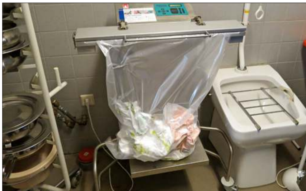
In Huize Het Oosten worden vuilniszakken gevacumeerd.
