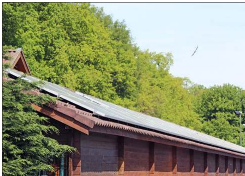
De zonnepanelen liggen op 'het oosten' en vrij van de bomen waardoor optimaal resultaat behaald kan worden.
