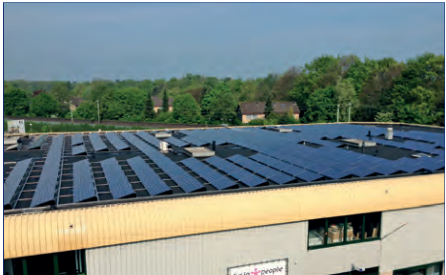
Het dak van De Leyensehof is volgeplaatst met zonnepanelen.
