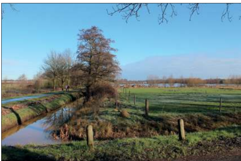
De route komt te lopen langs Voordorpsedijk door polder de Hooge Kamp.
