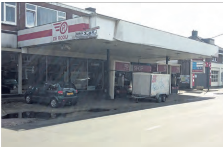
Opstallen, benzinepompen, overkapping en reclameborden van voormalig garagebedrijf De Rooij
