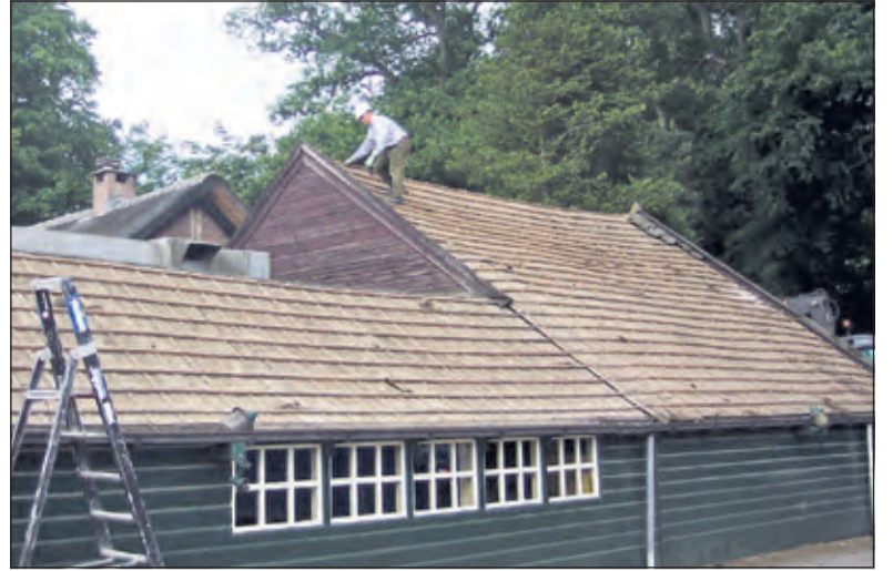
In 2008 werd het achterhuis van De Mauritshoeve gerenoveerd. Medewerkers van de aannemer halen de pannen van het dak.
