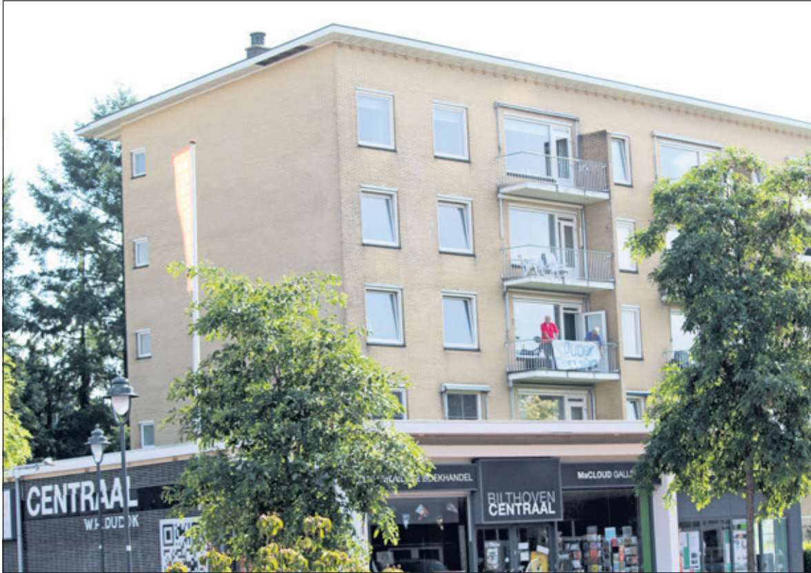
Spandoeken zijn nu nog zichtbaar. Als de voorgenomen bouw doorgaat zal de Julianaflat volledig aan het zicht onttrokken worden.
