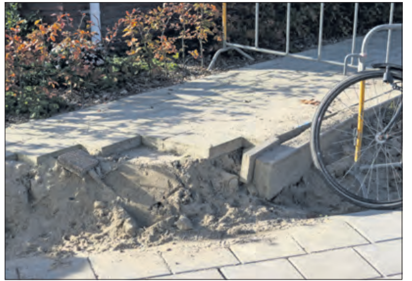
Wie trekt het boetekleed aan voor de lastige hoogteverschillen op de Leijenseweg.
