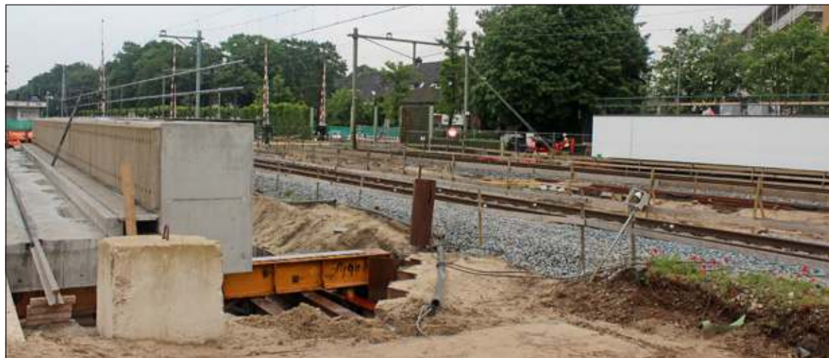
Vrijdag zullen de twee 'bakken' op hun plaats gebracht worden. De rails liggen er al in.
