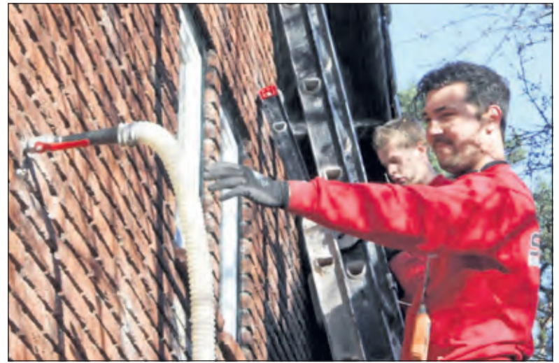
Loze ruimte in de spouw wordt opgevuld met isolatiemateriaal.
