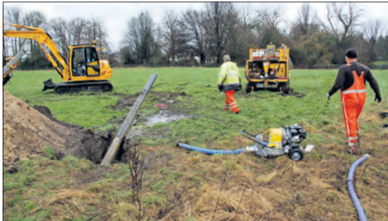
De buis voor de watervoorziening is onder de Utrechtseweg door aangebracht. Op het weiland komen brandrode runderen grazen.
