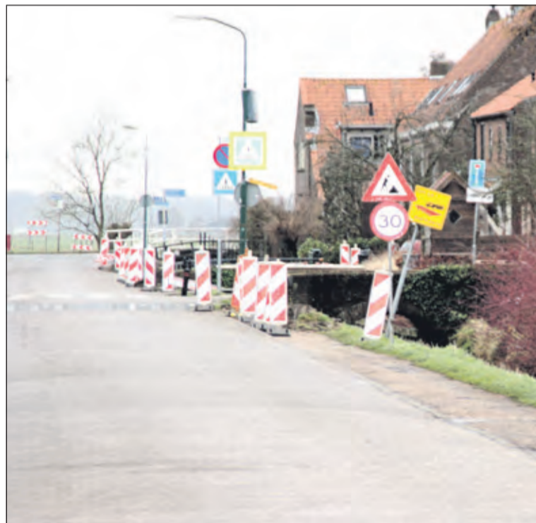
Langs de oostzijde van de Burg. Huydecoperweg binnen de bebouwde kom van Westbroek wordt op dit moment uitvoerig gegraven.
