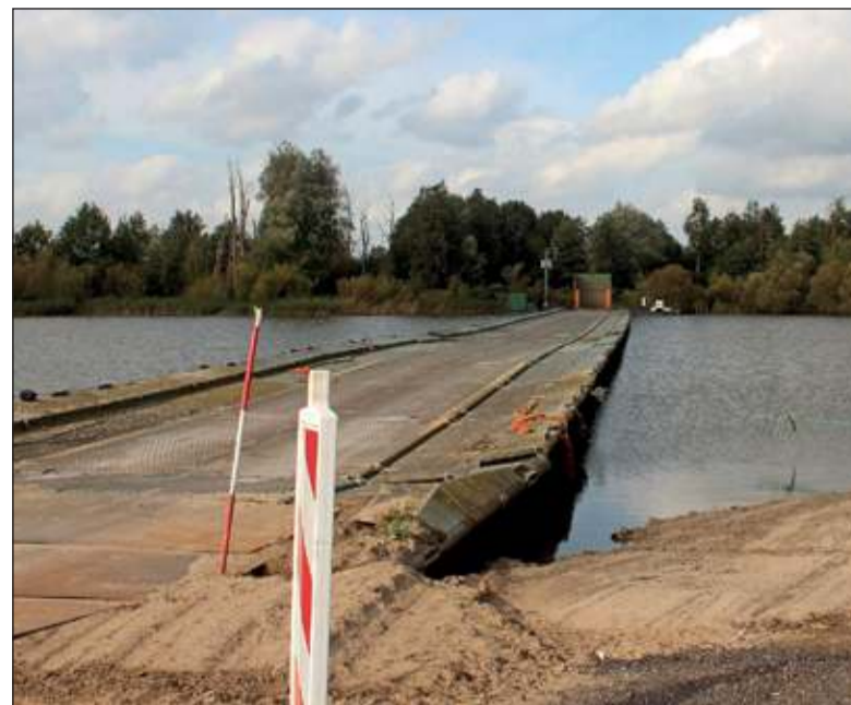
In de Hoogekampseplas zijn tijdelijke damwanden gelegd om de waterhuishouding te reguleren.
