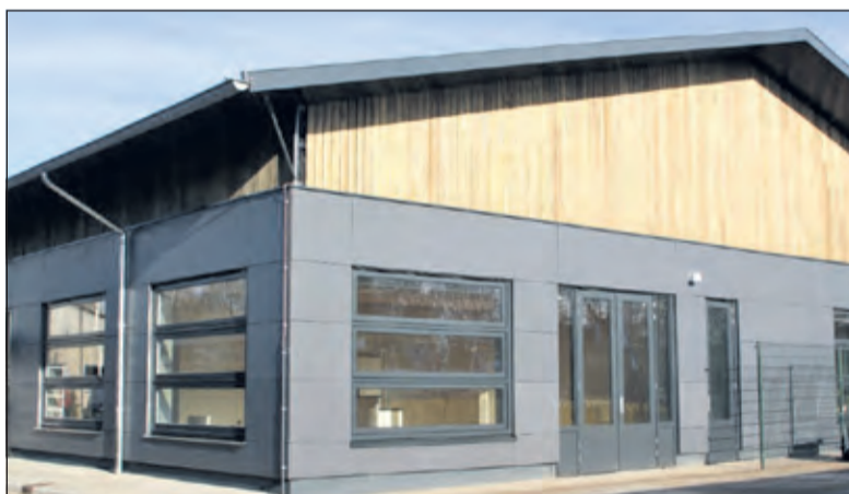
De gemeentewerf is te bezoeken. Er is daar geïnvesteerd in ventilatie, koeling en zonwering. Voor energieopwekking is gekozen voor een warmtepomp en zonnepanelen.
