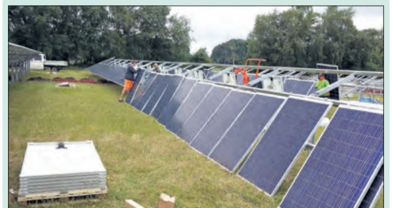
De aanleg van 989 zonnepanelen. [foto Rob Klaassen]
