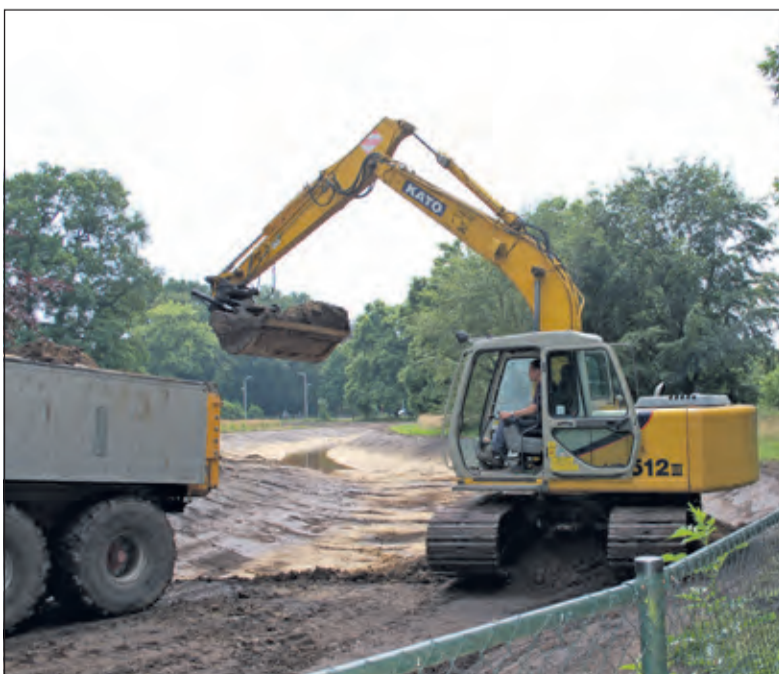
De nieuwe sloot wordt machinaal uitgegraven.
