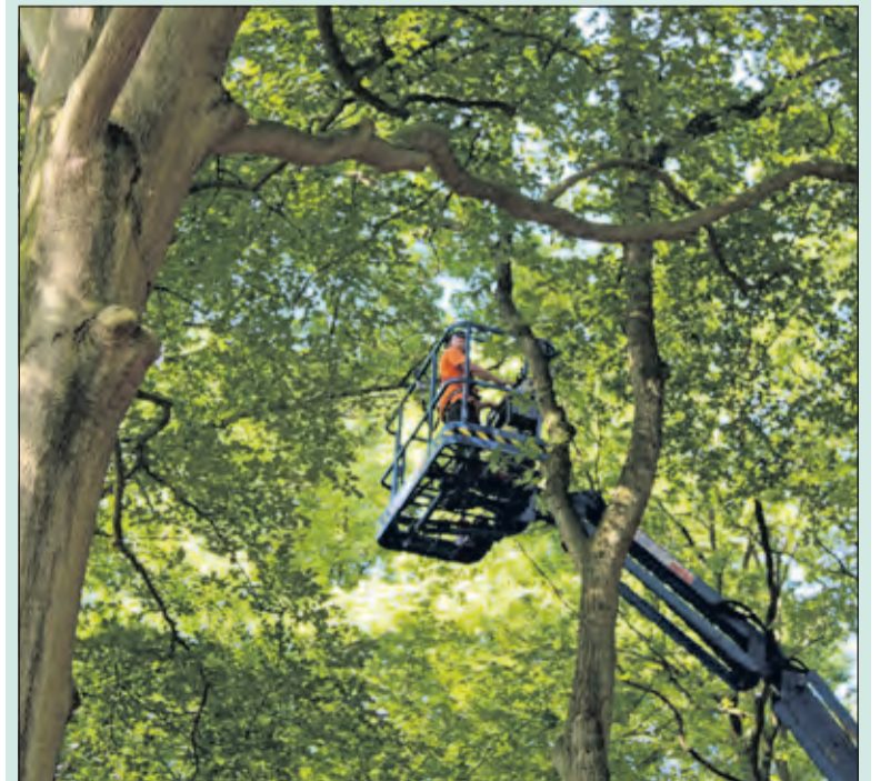
Inspectie en onderhoud op hoog niveau aan de Maartensdijkseweg.
