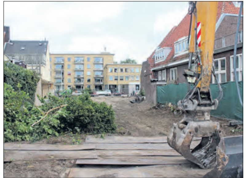
De verbindingsweg tussen Julianalaan en Vinkenplein wordt aangelegd. [foto sept. 2012 van Henk van de Bunt]
