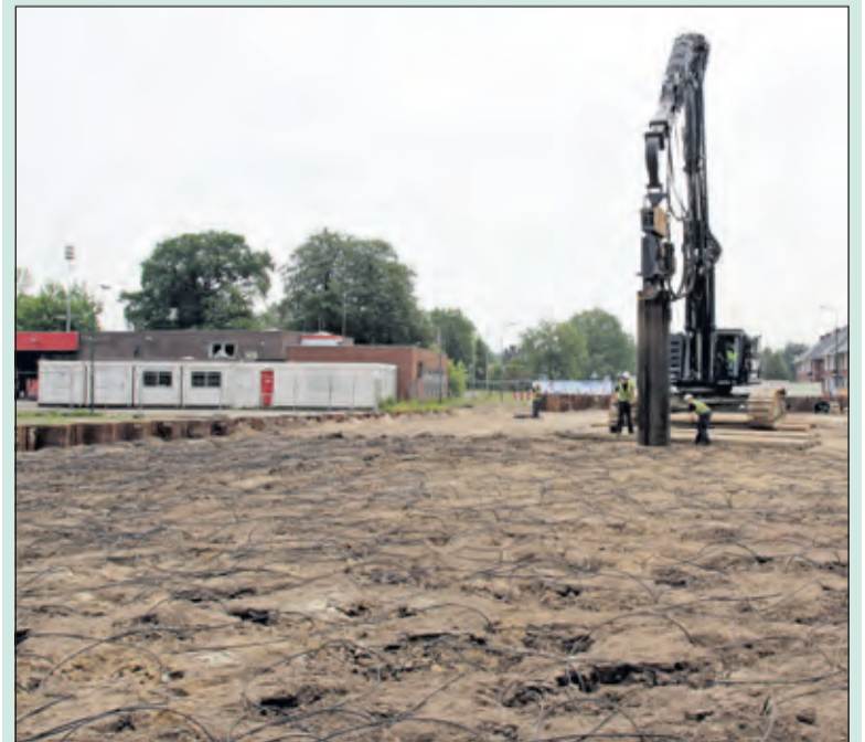
Op dit moment worden slangen aangebracht waardoor straks gel geïnjecteerd wordt waarna met de afgraving voor de bekisting begonnen wordt. [foto Reyn Schuurman]
