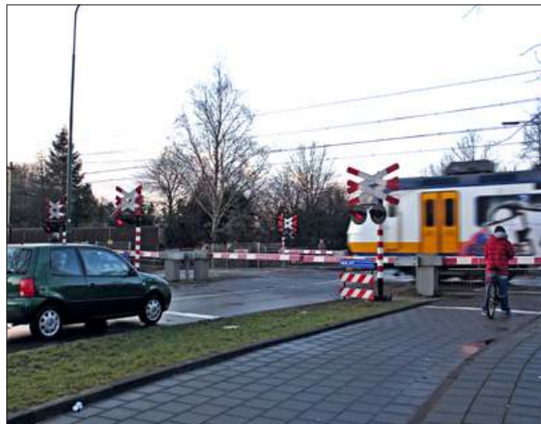
Ondertunneling van het spoor duurt 1½ jaar. Ontsluiting van de Leijen houdt de gemoederen bezig.
