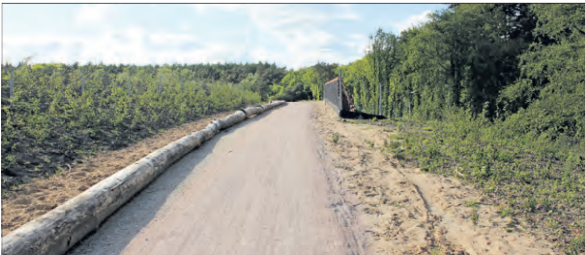
De nieuwe brug overspant de Utrechtseweg (N417) en heeft ook een fiets- en ruiterspad.
