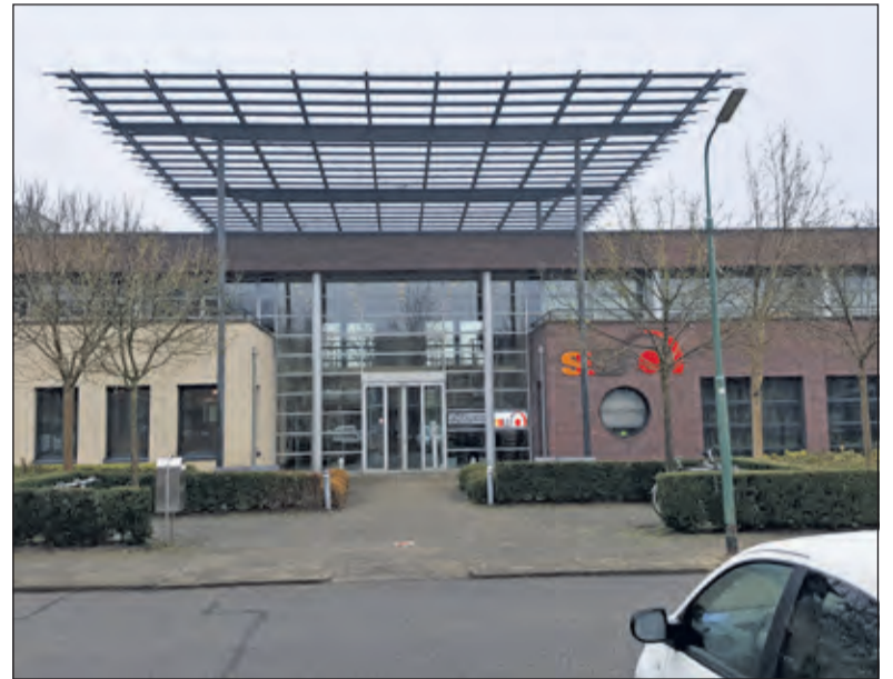
Wellicht komt de zendmast toch op het dak van het SSW-gebouw.
