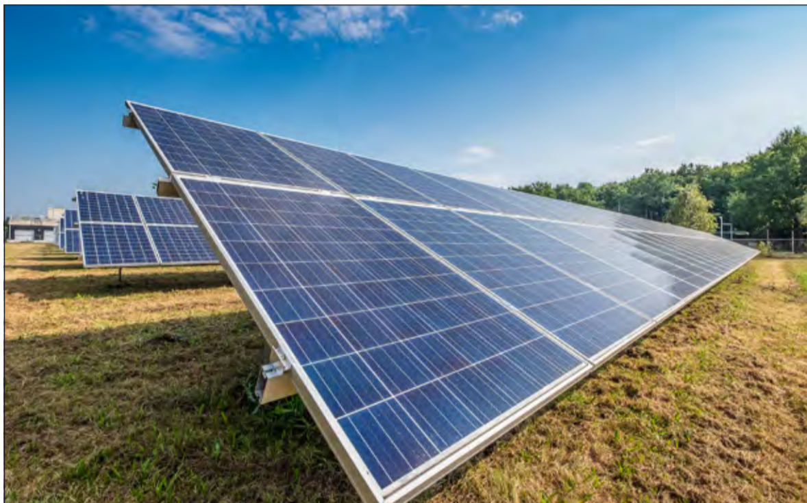
Energie opwekken door middel van zonnepanelen wordt steeds populairder. (foto Hans Lebbe - HLP images)
