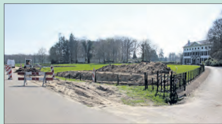
Provincie Utrecht is gestart met de werkzaamheden bij Vollenhoven. [foto Reyn Schuurman]
