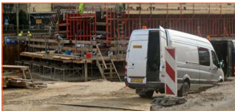
De Leijen: tijdelijke overweg opnieuw bekijken
