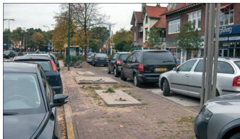
De sloop van het voormalig Esso-tankstation aan de Soestdijkseweg Zuid heeft ruimte gemaakt voor ontwikkelingen in het centrum.
