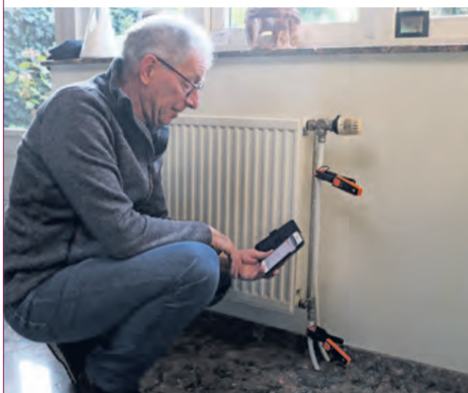
Energieambassadeur Frans den Braber demonstreert energiezuinig inregelen van de CV. Foto: Jenny Senhorst
