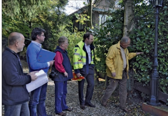
Vol ongeloof over zoveel schade vat een van de bewoners de uitleg samen: 'Dus tot deze hoogte moet alles worden weggesnoeid? En dat tot een diepte van 2,5 meter'? V.l.n.r. Ruud Kreutzer, v.d. Capelle, bewoonster, Martijn Korstanje en bewoner van naastliggende huis. (foto: Herman Spreitzer)
