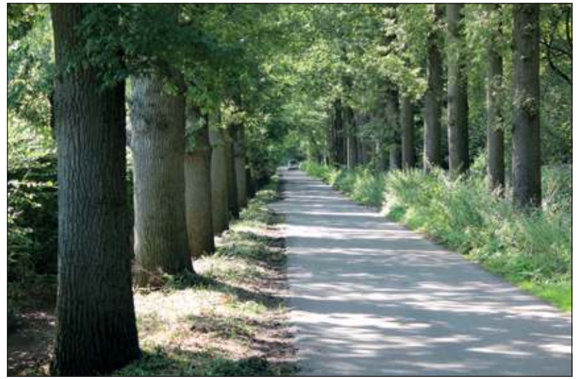
Bij een deel van de Eikensteeg ligt het geasfalteerde deel een stuk hoger, waardoor het water veel moeilijker weg kan.
