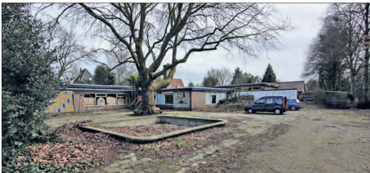
Op het terrein van de basisschool gaat gebouwd worden.
