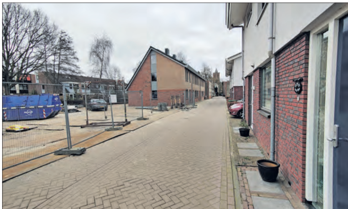
In goed overleg met de gemeente is in Westbroek een kleinschalig bouwproject vlot getrokken.
